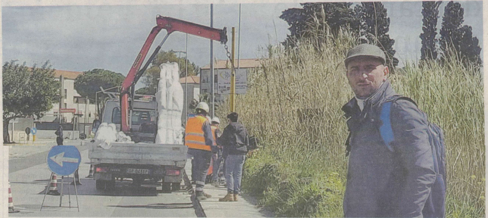
Il sopralluogo dell'assessore ai Lavori pubblici Giuseppe Nicastro
