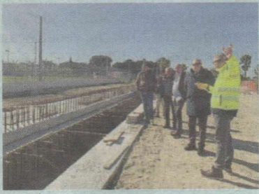
Il sopralluogo di Piazza
