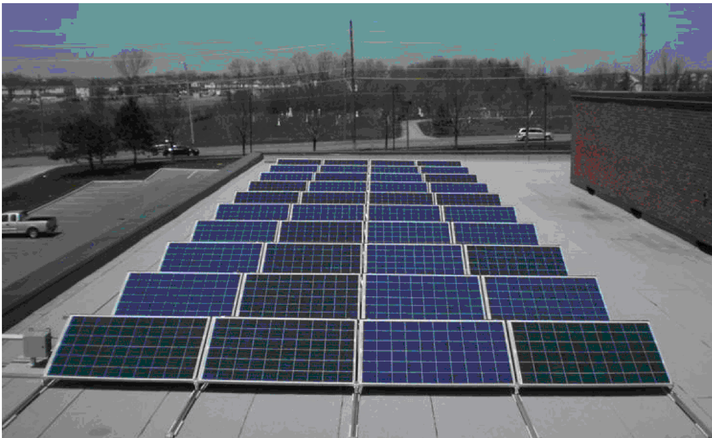
posizionamento tipo pannelli Fv su copertura piana
