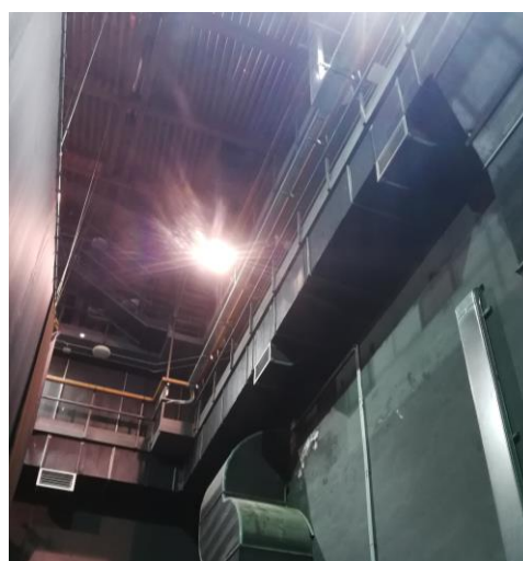
Figura 3 – Tipologico griglie e canale di ripresa aria in alto a quota sotto passerella palcoscenico
