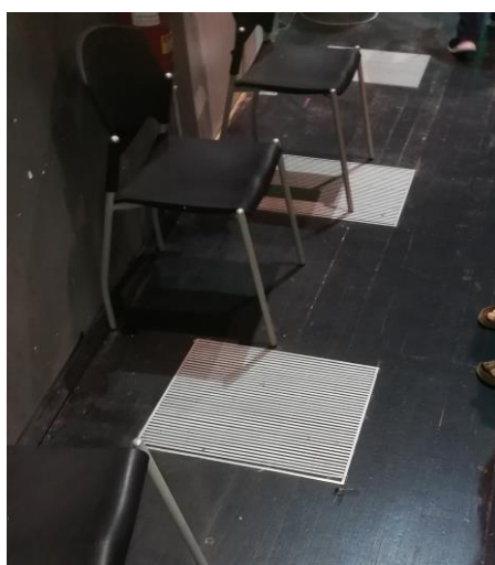
Figura 2 – tipologico griglia di mandata a pavimento
