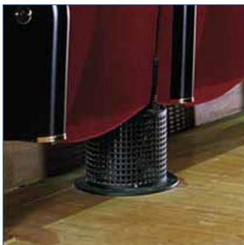
Figura 8 – Tipologica griglia di mandata a pavimento
