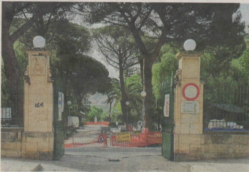
I lavori di riqualificazione alla villa comunale ancora in corso
