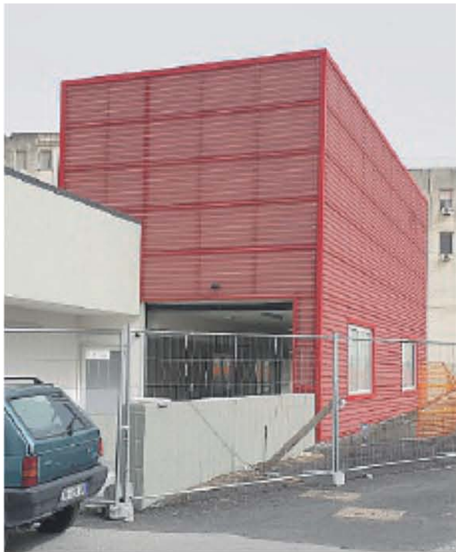
La ristrutturazione del Ps
