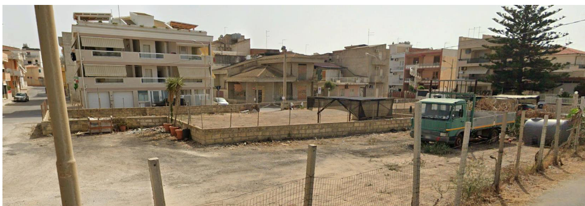
Immagine 5 - Punto di vista Sud-Ovest da via Neli Maltese
