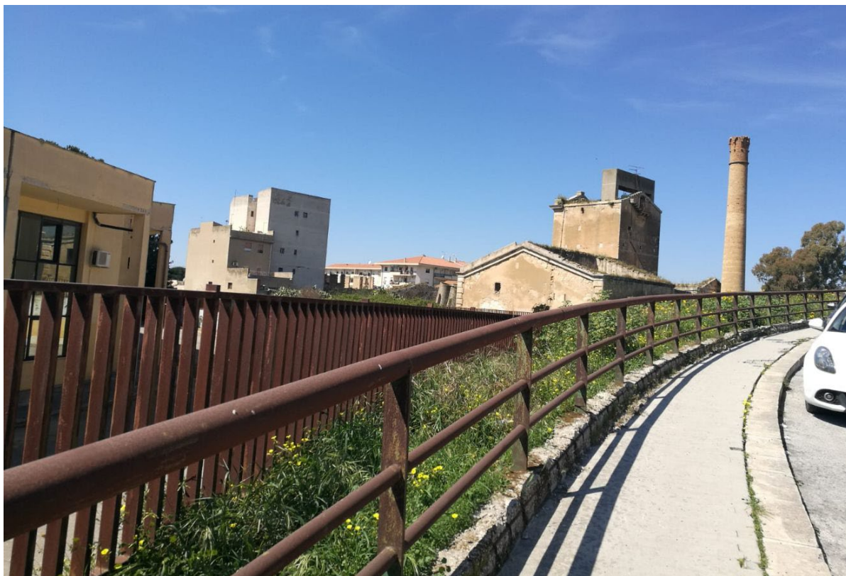
Figura 2 Via Ferdinando de Rosa (cavalcavia ferroviario)
