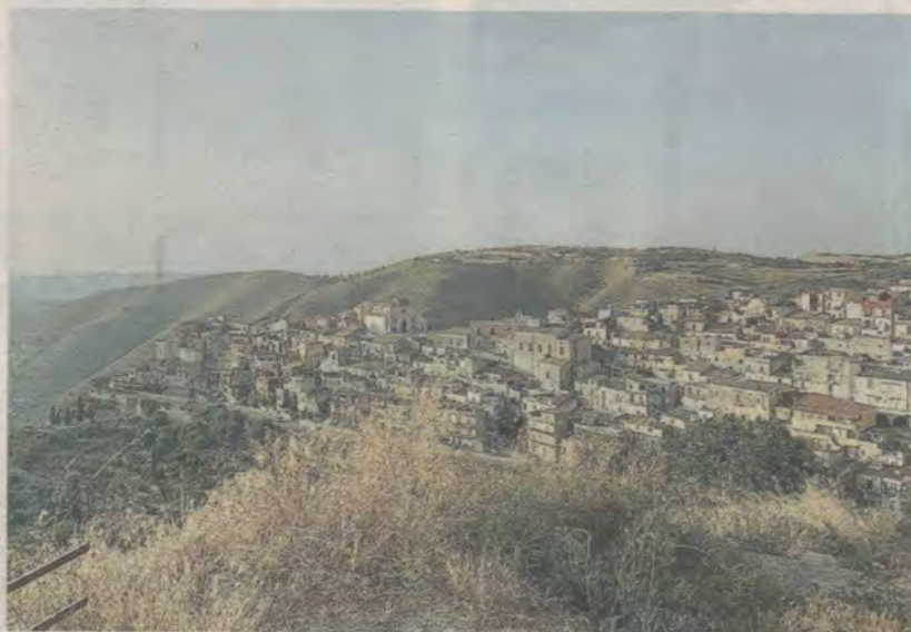
Una panoramica di Monterosso Almo tra le zone a rischio più elevato
