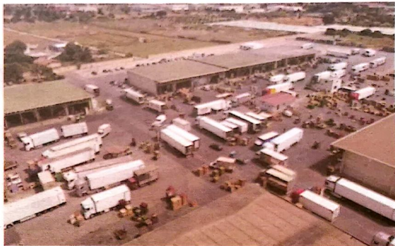
Una panoramica della struttura di contrada Fanello a Vittoria
