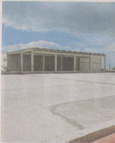
L'impianto di Pozzo Bollente
