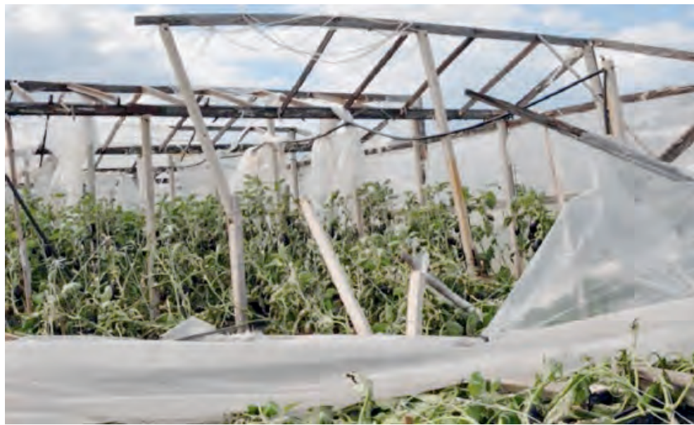
Una delle serre danneggiate dal maltempo. In alto a destra Francesco Aiello
